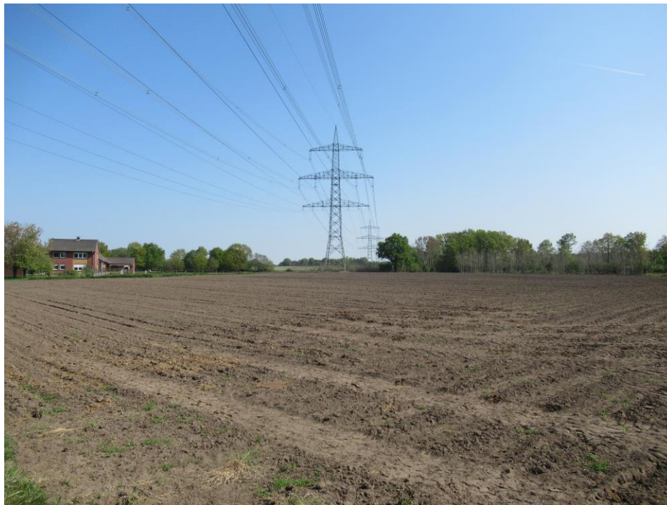
Abb. 18: Die Hochspannungsleitung südlich Bleking kreuzt den Nordwesten des UG. Foto: 2.5.22.
